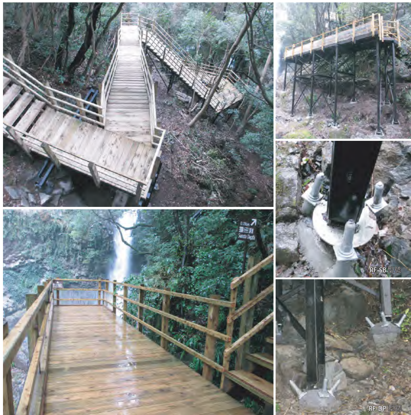
Rock Foundation 岩盤基樁工法 RF-SB/RF-DP 型號 施工範例
