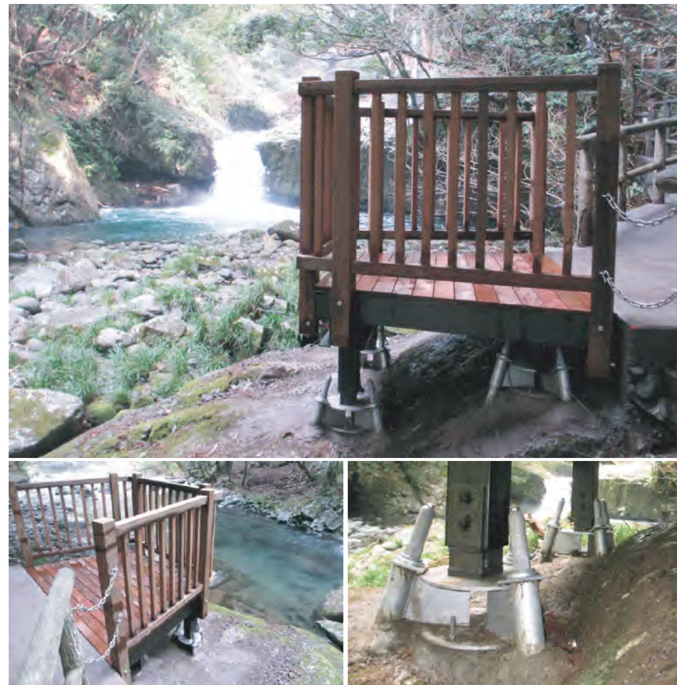
Rock Foundation 岩盤基樁工法 RF-SB 型號 施工範例
