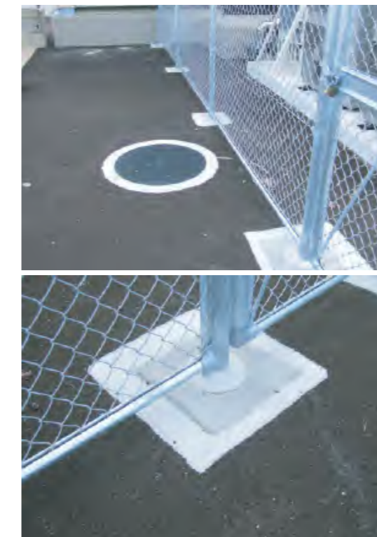
混凝土基樁塊 □300×300×800
