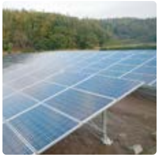
安裝角度20° Mounting angle: 20°
