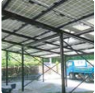
在柱子下方保留空間的施工案例 The case of using long posts to make a space
