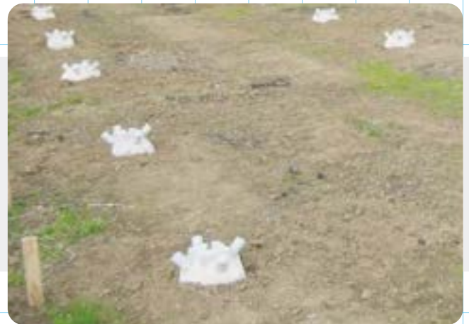
05 基礎設置完成 Completion of Foundations
