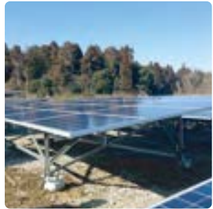
安裝角度5° Mounting angle: 5°
