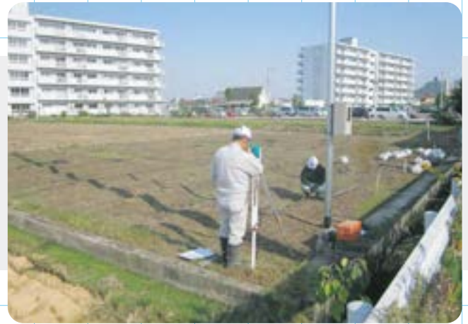
02 測量基礎位置 Surveying
