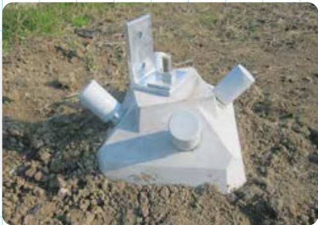
06 安裝柱腳零件 Installing Brackets
